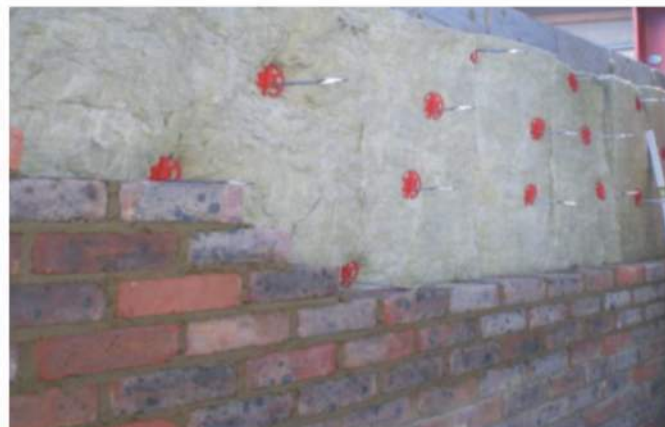
Zdj.2 Sposób montażu łącznika ST1 i talerza dociskowego
