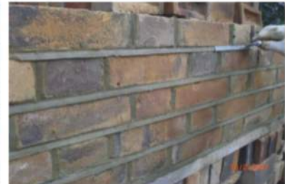
Zdj.3 Spoina daszkowa ... właśnie tak można ukryć nierówność cegieł licowych i przy okazji zapewnić dobry spływ wody
