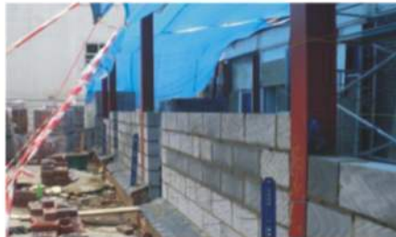
Zdj.2 Blockwork zabezpieczenie p.deszczem
