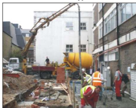
Zdj.3 Przy większym betonowaniu warto rozważyć beton z tzw.gruszki (mixer)
