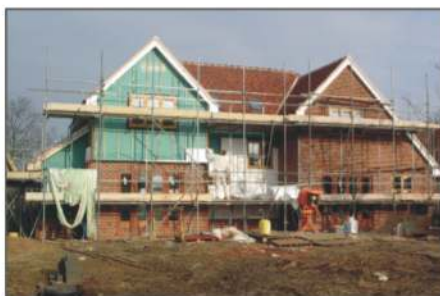
dom w okolicach Stansted, "stara" cegła klinkierowa plus tynk w systemie dociepleń
